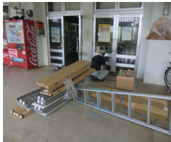
古い蛍光灯の取り替え
